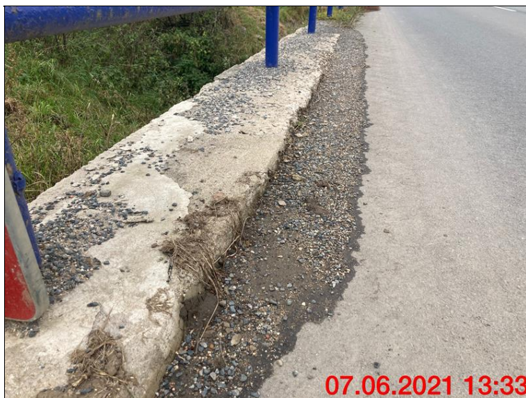
11.Nános nečistot na vozovce podél pravé římsy.JPG
