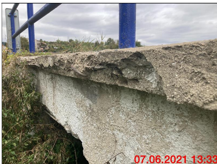
09.Rozpad římsy vpravo.JPG
